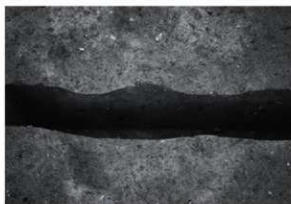
RF42 断面 (東から)
