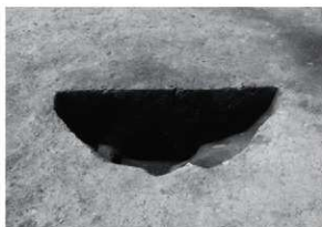
RB06 PPB1102 断面 (南西から)
