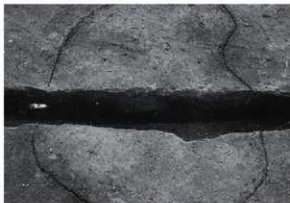
RF09 断面 (北西から)
