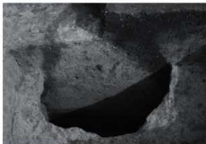
RD19 断面 (南西から)
