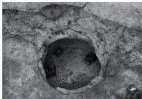
RD16 全景 (西から)
