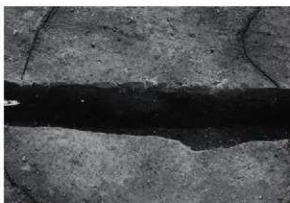
RF09 断面 (北西から)
