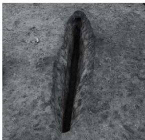
RD79 全景 (南から)
