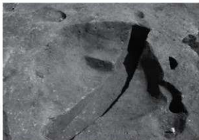
RD77 全景 (西から)
