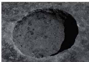
RD02 全景（北西から）
