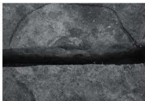
RF19 断面 (南から)
