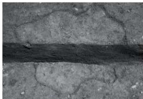
RF41 断面 (南から)
