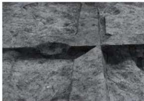
RA27断面近景(西から)
