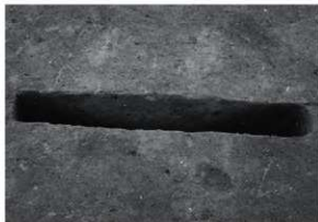
RF02 断面 (北西から)
