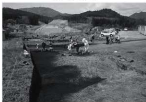
西端低地作業状況
