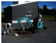
写真39 掘削状況(S-1)
