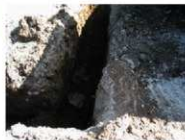
写真40 掘削状況(H-1)
