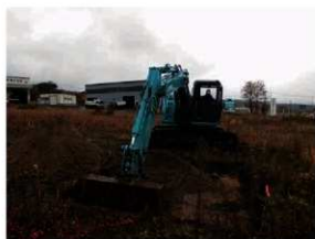
写真52 掘削状況(S→)
