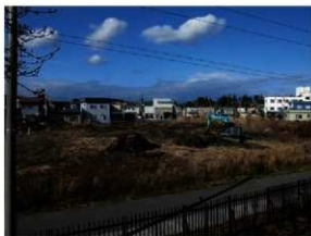
写真60 掘削状況(E→)
