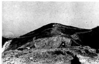
土取り工事が進む北平尾根
