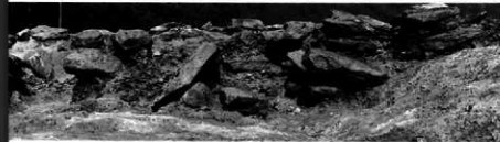
裏込と基壇の断面 (右端は第2石柵)
