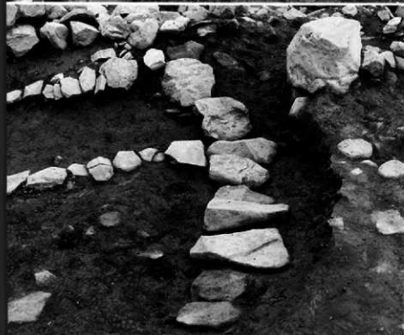
同上、南より（壁体最下段のみ）
