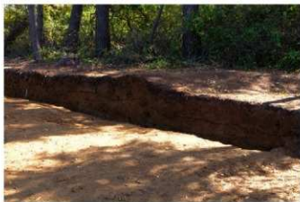
南壁断面 (北西より)
