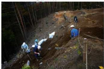
法面掘削作業
