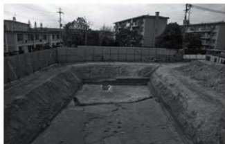
図20 外大門川の旧河道 （市HJ319次調査地、東から）
