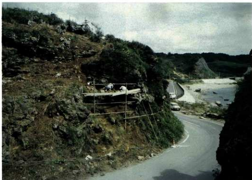
1号基調査風景
