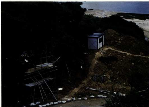
2号基調査風景
