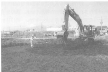
写真1 重機による表土除去
