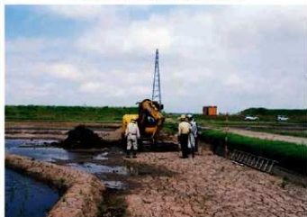
新通遺跡 13トレンチ調査風景 (南東から)
