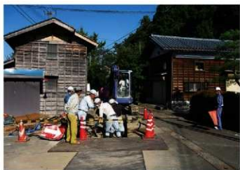
花立遺跡 調査風景 (西から)
