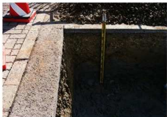
花立遺跡 土層断面 (北西から)
