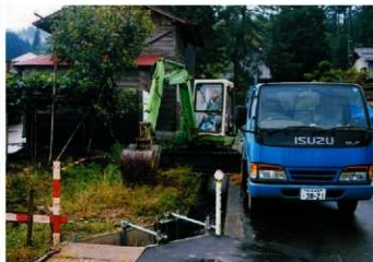
元狭口遺跡 調査風景 (北東から)
