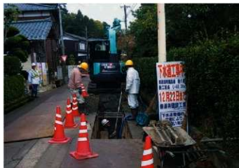
花立遺跡 調査風景 (北東から)
