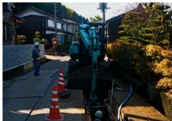
花立遺跡 調査風景 (北東から)
