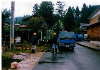
元狭口遺跡 調査風景 (北東から)
