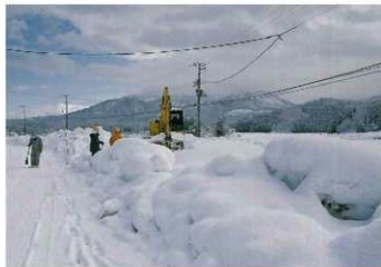
たて屋敷遺跡 3 トレンチ調査風景 (西から)
