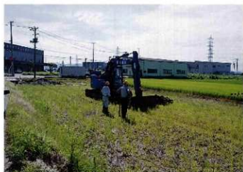
後須田地区 調査風景 (北西から)
