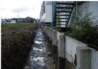
中沢遺跡 排水路改良区調査後状況(南から)
