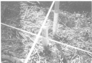
写真20 測点杭の設置
