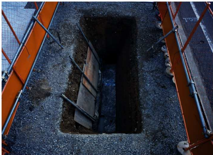
写真34 3区全景 遺構検出状況 -北から-
