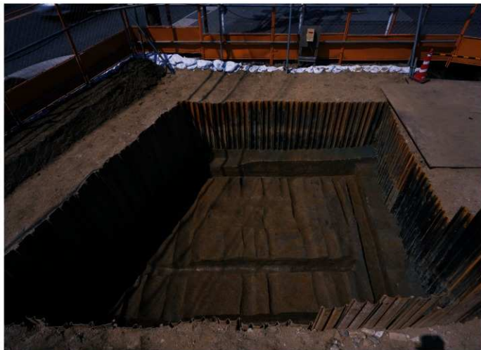
写真 17 南区全景 上層造構完備状況 - 東から -
