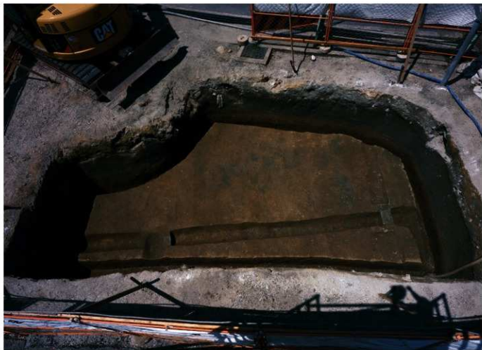
写真3 上層造構完振状況 - 南から -
