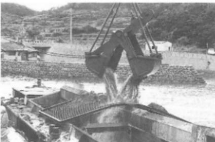
浚渫した土砂を土運船の上に落とす
