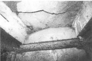
②羨道天井石の亀裂状況(東から)
