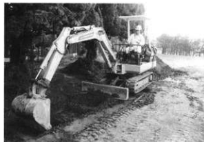
重機による造成土の除去（1-1区）
