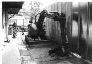
重機による舗装部分の除去（2-5区）
