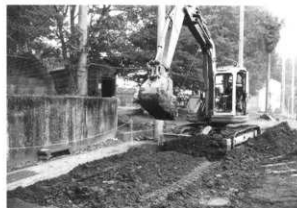
重機による埋め戻し状況（1-3区）
