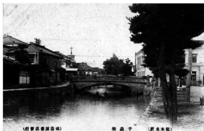
写真22 明治42年(1909)頃の千歳橋(大手門門台石垣が転用された石橋)を写した絵葉書。右側木の奥の建物は松本郵便局(明治22年施工)、橋の奥には開智学校が見える。両建物ともに立石清重の設計・施工である。(文献2)
