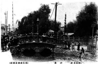
写真23 明治43年頃の御幸橋を写した絵葉書。大手門の門台石垣が利用された。(文献2)
