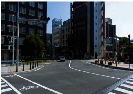
ビル解体前の調査地 南側の千歳橋より撮影
