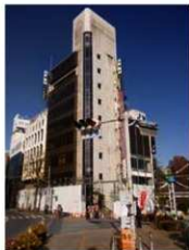
写真1 解体されるビル
