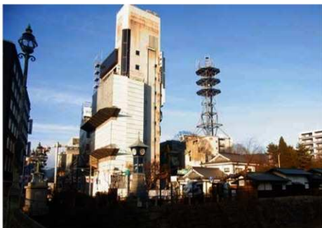
解体中のビル (旧鶴林堂ビル・旧ノセビル)
