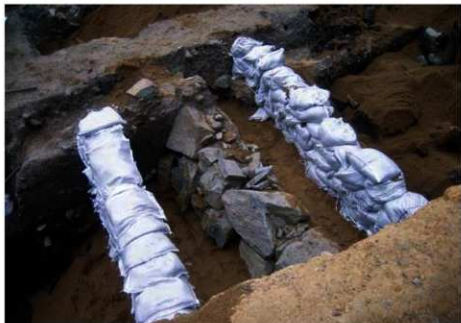
埋め戻し状況
