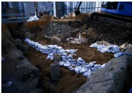
埋め戻し状況
