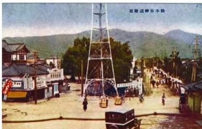
写真24 大正時代末から昭和初期頃の大手門桁形跡(調査地付近)火の見櫓の奥に、まだ総堀の一部が埋められずに残っている。右側は縄手通り。(文献2)
