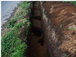
同 完掘状況 (東から)
