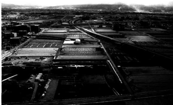
調査区を北より望む。右側より奥に伸びる中部横断道と交差する長野新幹線。奥の山並みは蓼科山麓
