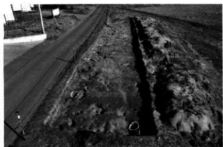
B区全景（南西から）
