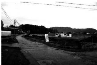
平成24年度表土除去作業（南から）
