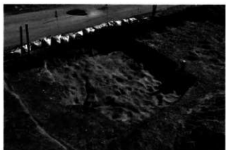
H7号住居址掘方（北西から）
