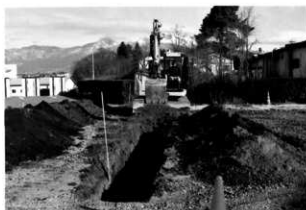
トレンチ掘削状況
