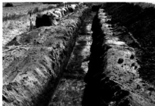
トレンチ掘削状況
