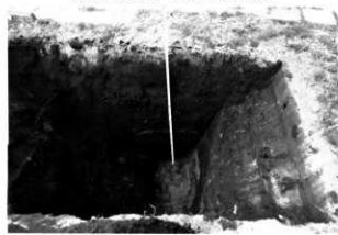
対象地北東部 トレンチ掘削状況
