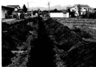
トレンチ掘削状況
