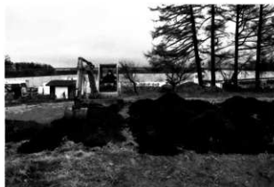
トレンチ掘削状況
