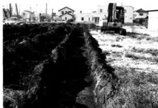
トレンチ掘削状況
