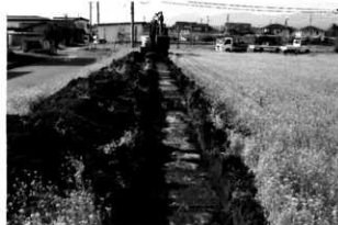
トレンチ掘削状況
