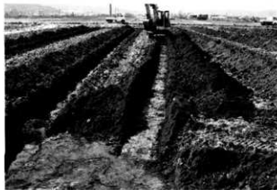
トレンチ掘削状況
