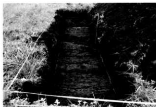
トレンチ掘削状況
