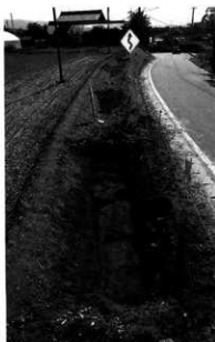
トレンチ掘削状況
