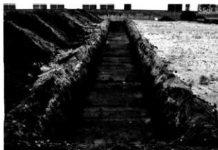
トレンチ掘削状況
