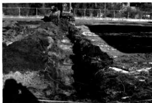
トレンチ掘削状況
