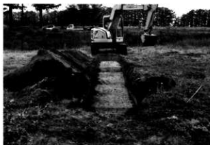
トレンチ掘削状況
