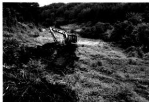
トレンチ掘削状況
