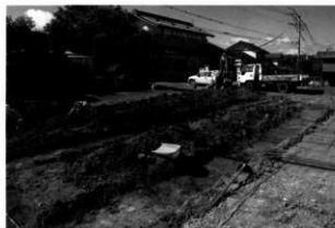
トレンチ掘削状況
