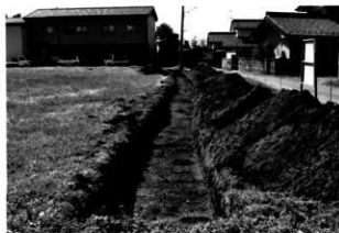
トレンチ掘削状況
