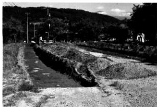
トレンチ掘削状況
