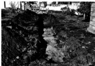
トレンチ掘削状況
