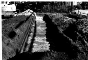
トレンチ掘削状況
