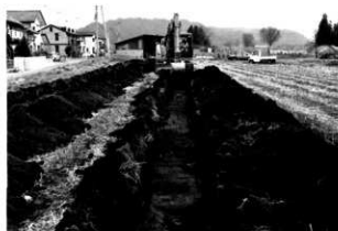
トレンチ掘削状況
