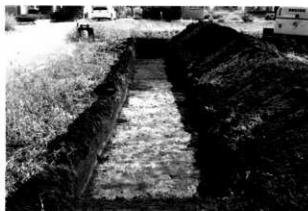
トレンチ掘削状況
