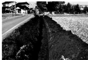
トレンチ掘削状況
