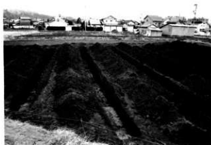
トレンチ掘削状況
