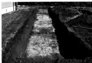
トレンチ掘削状況
