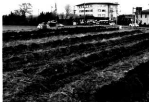
トレンチ掘削状況
