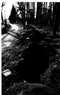
トレンチ掘削状況
