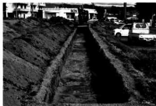
トレンチ掘削状況
