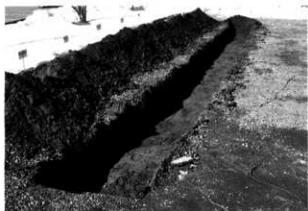
トレンチ掘削状況
