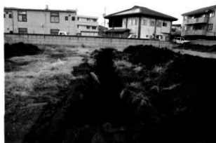
トレンチ掘削状況
