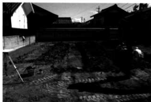
トレンチ掘削状況
