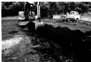
トレンチ掘削状況
