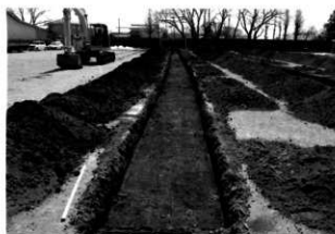
対象地南側 トレンチ掘削状況
