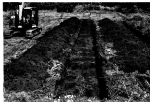
トレンチ掘削状況
