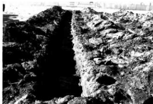
トレンチ掘削状況
