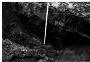
対象地北東部 トレンチ掘削状況
