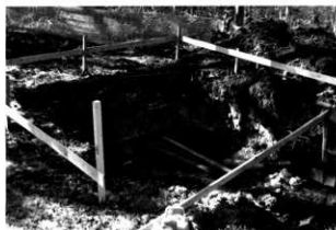
トレンチ掘削状況
