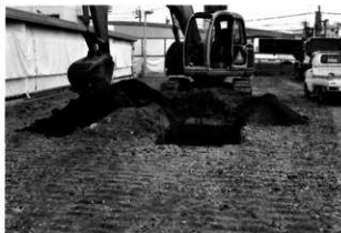
トレンチ掘削状況
