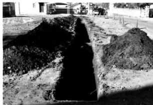
トレンチ掘削状況
