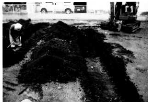
トレンチ掘削状況
