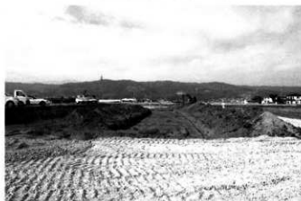
調査開始前状況（北東から）
