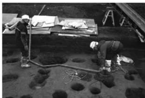
水汲み作業 西から
