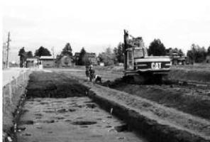
埋め戻し作業 南から
