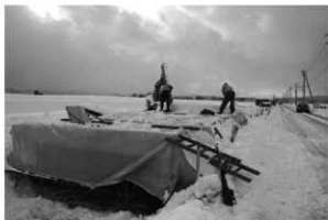
除雪作業 北から
