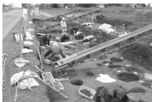
遺構の監視 南西から
