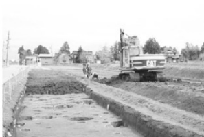
埋め戻し作業 南から
