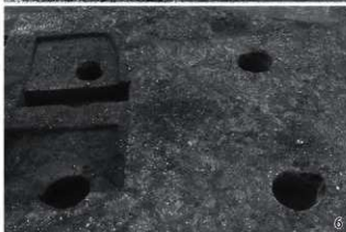
6 ST6001 完掘状況 (北より)
