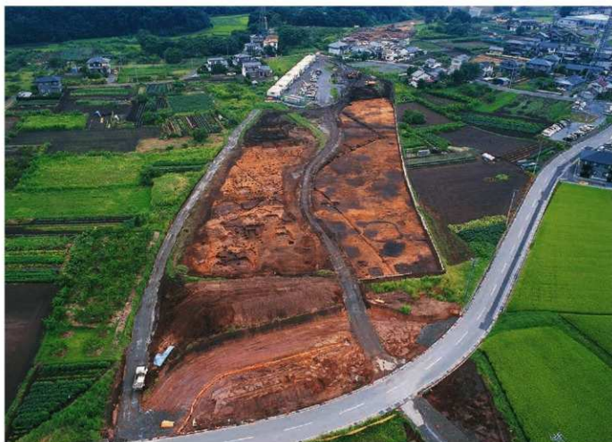
3区（左側）完掘状況と4区（右側）検出状況（南より）
