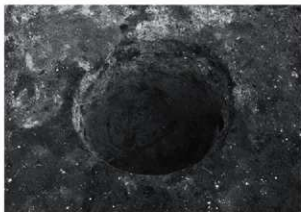
ST0304 P6 掘方完掘状況 (西より)
