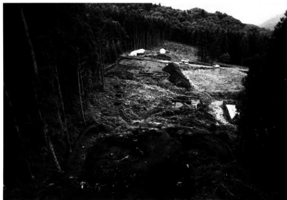
全景（北側上空より）
