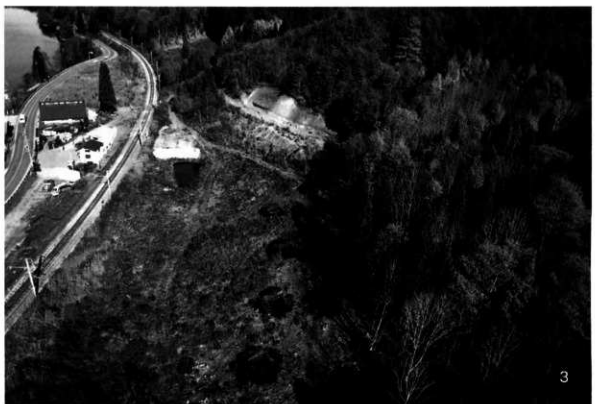
3. C地区全景（南側 上空より）
