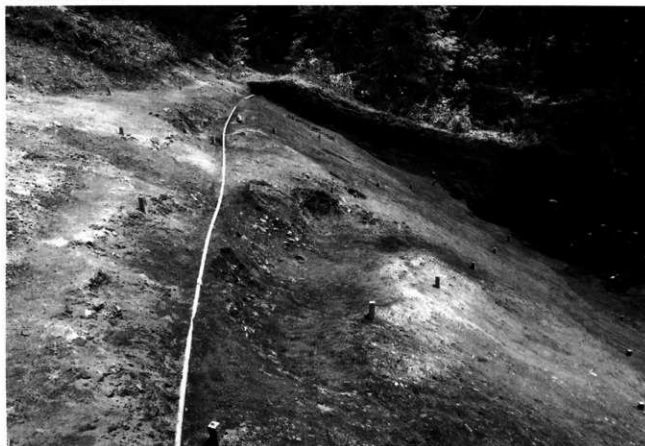
1・2・4・5号住居跡（東より）手前が1・4・5号住居跡後方が2号住居跡。
