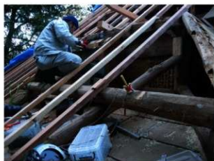
02 同屋根背面(修理中・北から)
