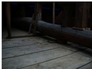
11 同小屋組内部
