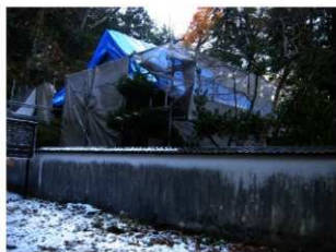
01 大日堂近景(修理中・北西から)
