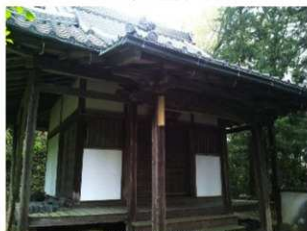
15 大日堂修理後全形(正面)
