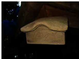
13 同北東隅尾垂木の隅瓦
