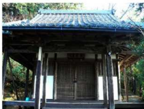
CUT 05 大岩大日堂近景（修復前・平成18年撮影）
