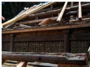
09 大日堂正面の小屋組上部1(近景)
