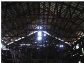
CUT 03 北六田・北村化学倉庫の内部（平成24年撮影）
