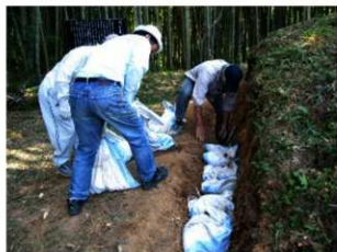
14 墳丘保護作業の様子1(東から)
