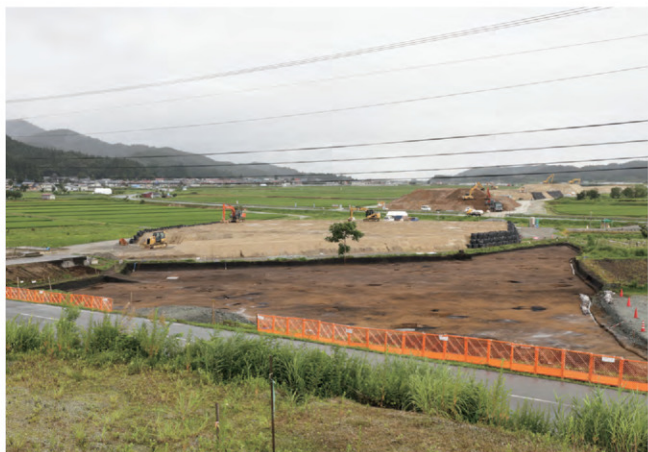
調査区全体遺構完掘状況（北から）
