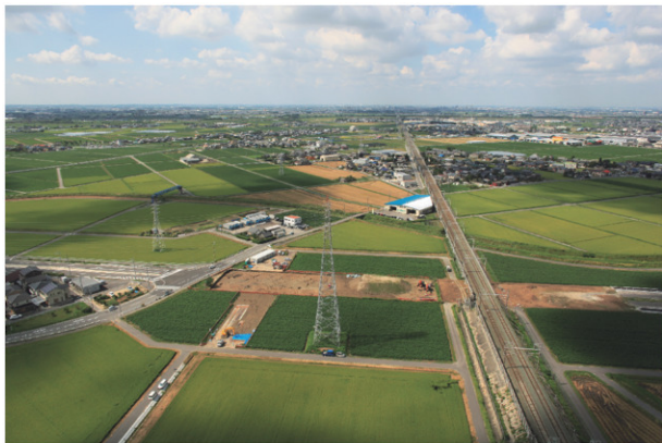
調査地点遠景（南東から）
