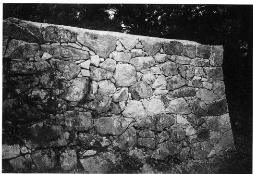
修復後の状況（南から）
