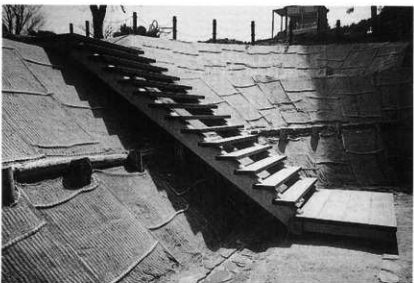
園路デッキ設置状況
