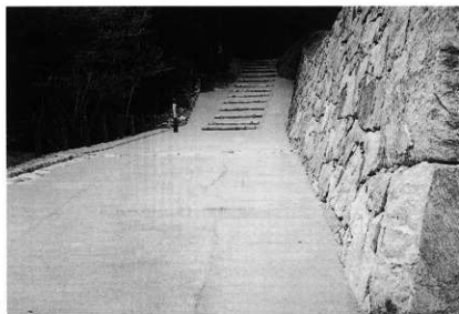
山中御殿平園路整備状況
