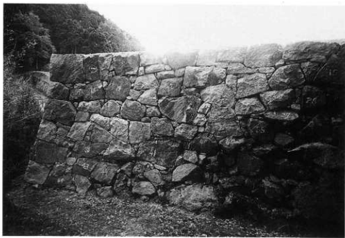
修復後の状況（東から）
