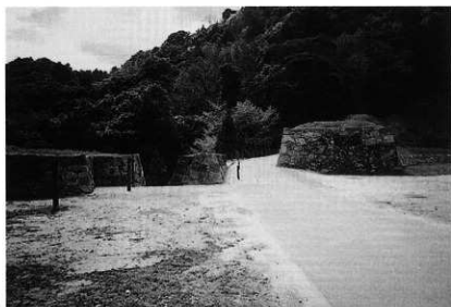
山中御殿平園路整備状況
