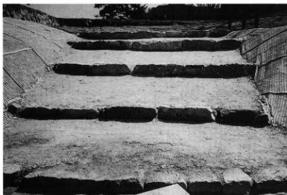
山中御殿平虎口階段 整備状況
