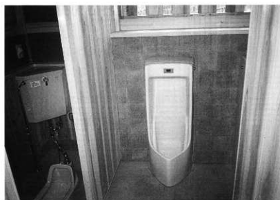
花ノ壇便益施設設置状況
