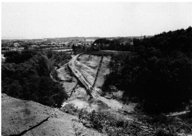
I区 調査区全景 (西より)
