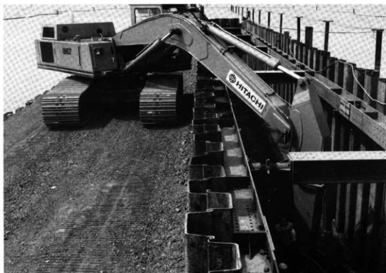
1. 大型バックホーによる掘削
