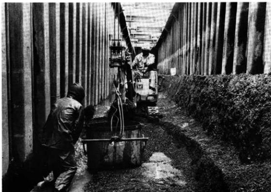
2. 表土掘削状況
