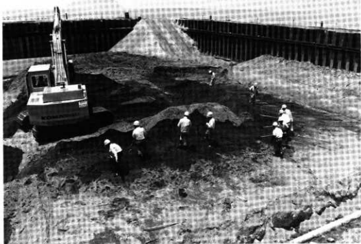
(1) 包含層掘削作業風景
