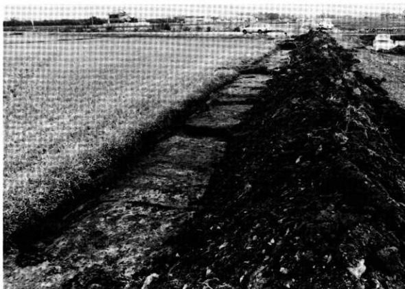
No.19+60~No.20トレンチ (西より)
