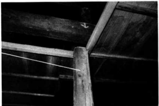
柱頭部切断されている後補柱
