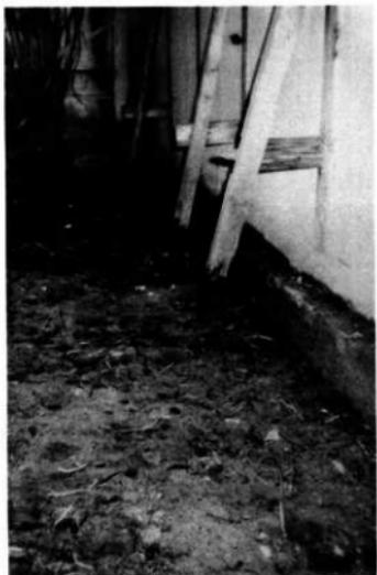
186 屋敷南側廻、柱柱腐朽状況
