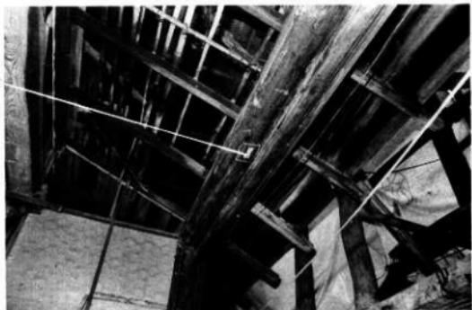
215 流し場東側旧軒桁に残る柱納穴（そ7柱）
