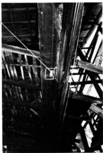
217 流し場東側旧軒桁に残る柱納穴（そ3柱）
