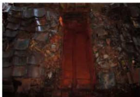
煙出調査状況
