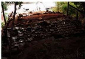
煙出上面の屋根瓦
