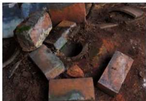
9 房天井露抜き穴
