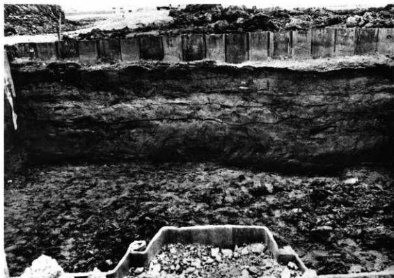
2号桥梁上层土層堆積状况
