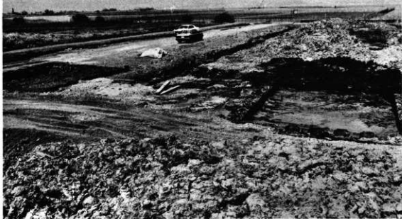
2号橋梁調査前全景（上流より琵琶湖を望む）
