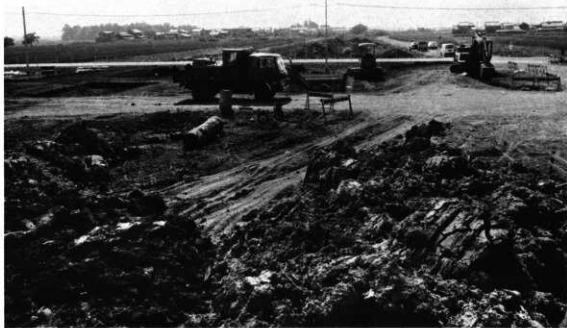
3号橋梁調査前全景（下流より杉江・山賀の集落を望む）
