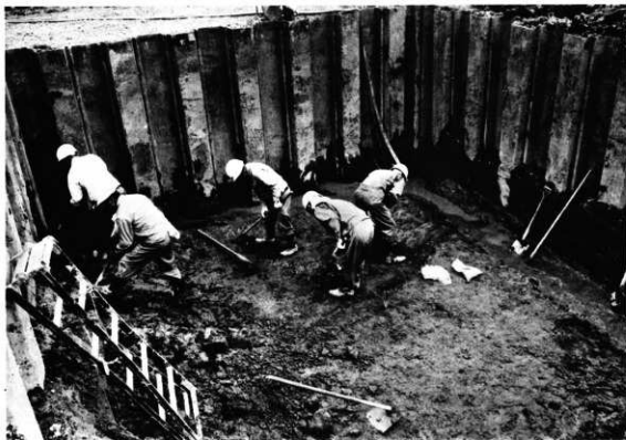
2号橋梁調査風景
