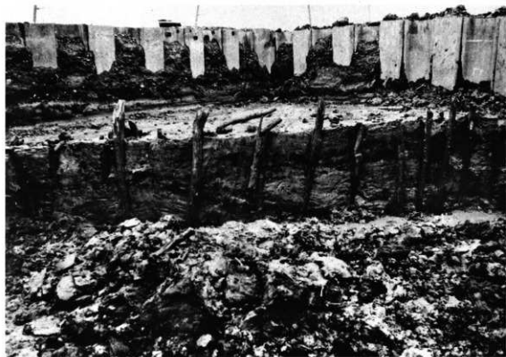
2号桥梁桩列出土状况
