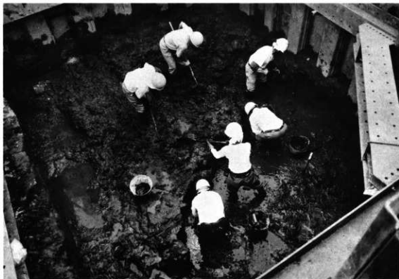
3号橋梁調査風景
