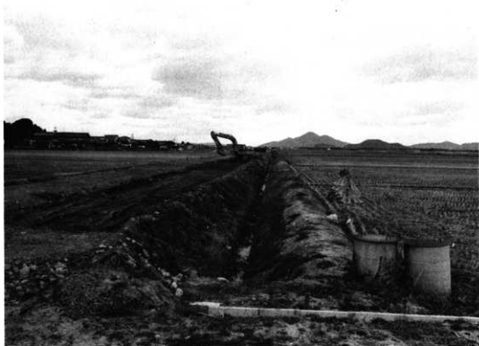
H04・H05埋めもどし状況（南より）
