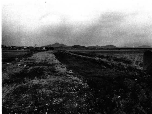
H04埋めもどし状況（南より）
