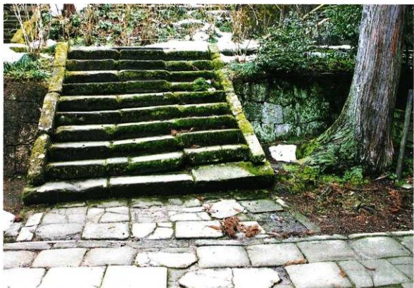
同 上(五代廟所入口付近)
