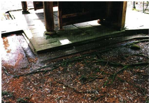
既設排水路(八代廟門付近)
