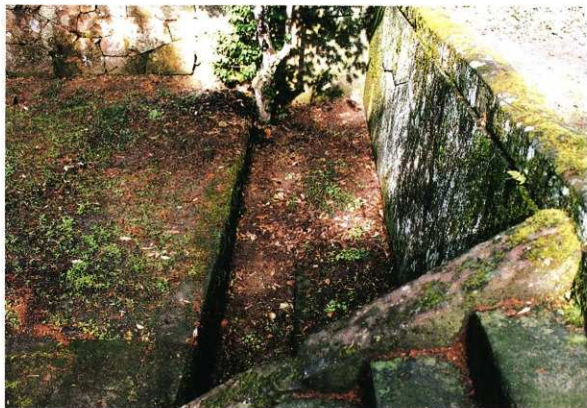
既設排水路(八代廟所前)
