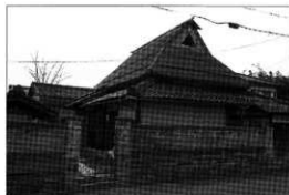
鹿島家住宅外観
