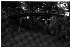
保存修理を完了した飛梁溪橋
