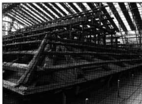
御書院の解体（小屋組）
