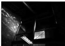
土間天井の小屋組み
