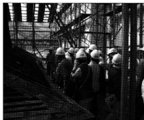
楽々園御書院解体修理の現地説明会
