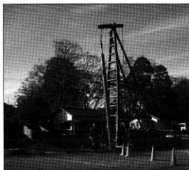
さく井工事状況
