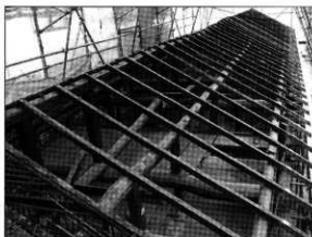
解体修理で小屋組みが露呈した旧池田屋敷長屋門
