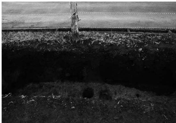
4SI10 土層観察状況状況 (西から)
