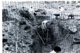
o 大溝掘削状況
