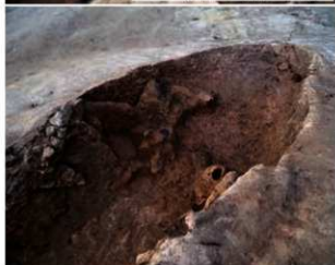
001SY ダンパー・煙道部
