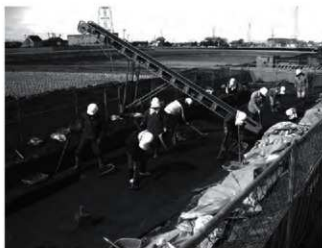
図30 須ヶ谷遺跡 05B区作業風景
