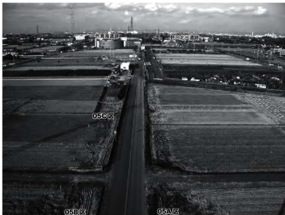
図23 須ヶ谷遺跡調査区全景 南から
