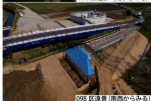
09B 区遠景 (南西からみる)
