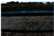
08Aa 区 1 面中央部 (東からみる)
