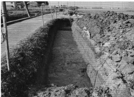
1. 東発掘区全景（東から）
