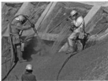
写真23 補強土工吹き付け
