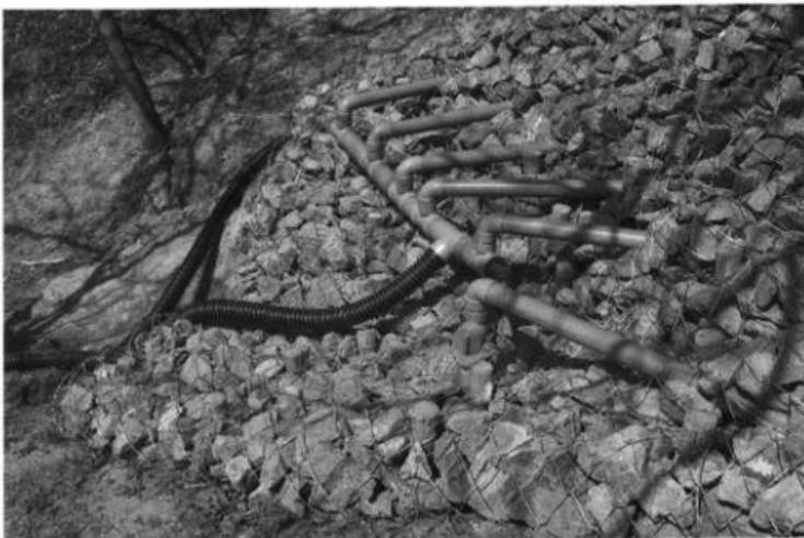
写真19 地下水排除工
