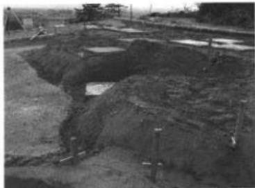
写真30 復元造橋周辺の路盤工
