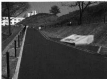
写真50 脱色系アスファルト舗装
