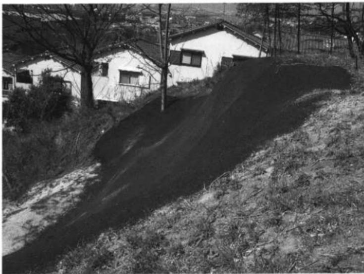
写真26 A側線滑落崖の保全工事補強土工
