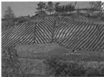
写真21 裏面排水の設置
