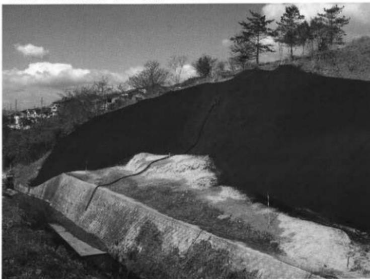
写真27 C側線滑落崖の保全工事補強土工
