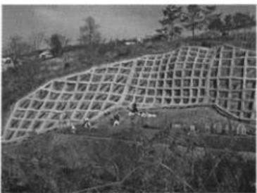
写真22 法枠工（鉄筋挿入）
