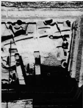
63C区下面全体 (南から)
