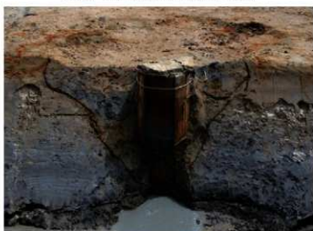
07A区 0101SE断ち割り状況 北から
