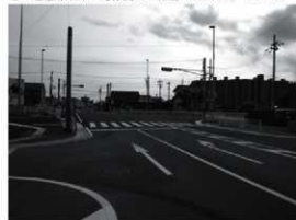
塔の越遺跡東部・跨線橋入口付近：08Ab 区・09A 区
