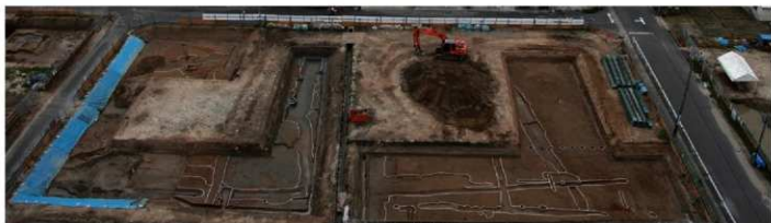
07C区 全景 北から
