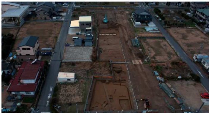
07B区 1面全景 東から
