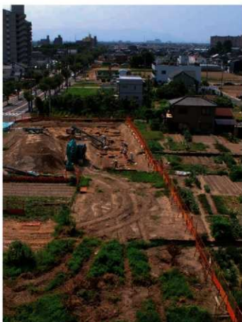
08Aa区 遠景 東から
