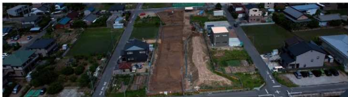
07A区 1面全景 西から
